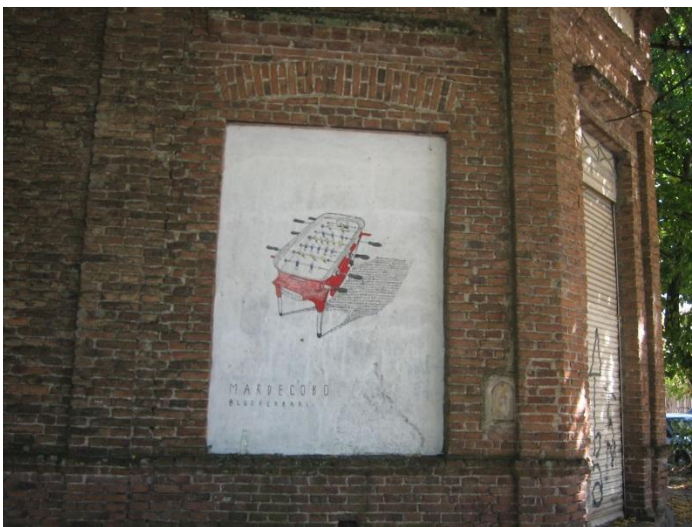
22 y 65 “mardecoco” casa particular abandonada
